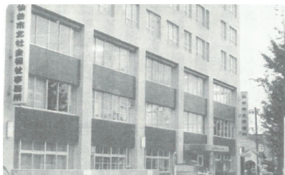
外記丁庁舎(現在の錦町庁舎)に事務所移転(昭和43年)
